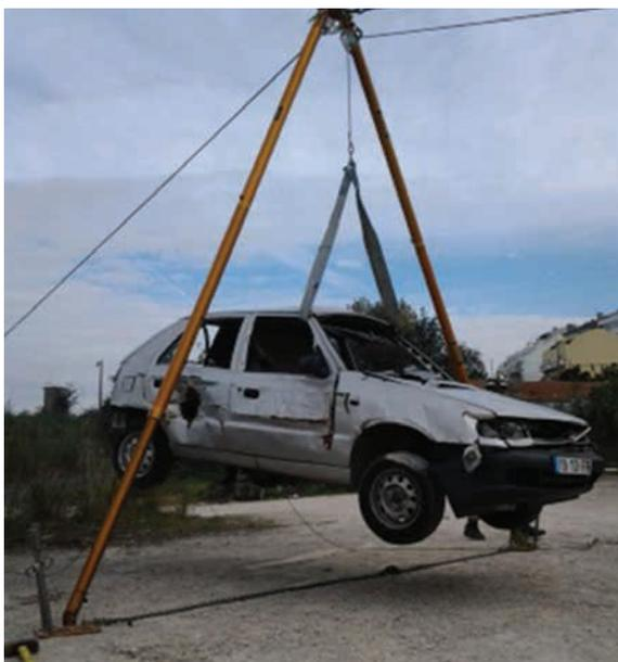
Figura 10 - Movimentação de cargas com recurso ao Bipod (bipé) *kit* da Paratech
