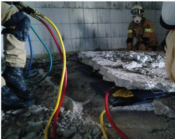
Figura 9 - Movimentação de cargas com recurso a *Kit* de almofadas de alta pressão
