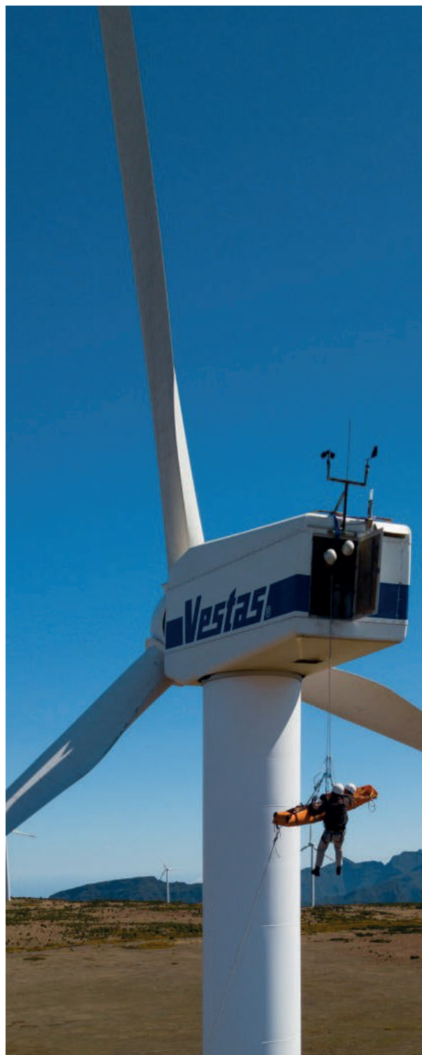
Figura 7 – Intervenção em torres eólicas
