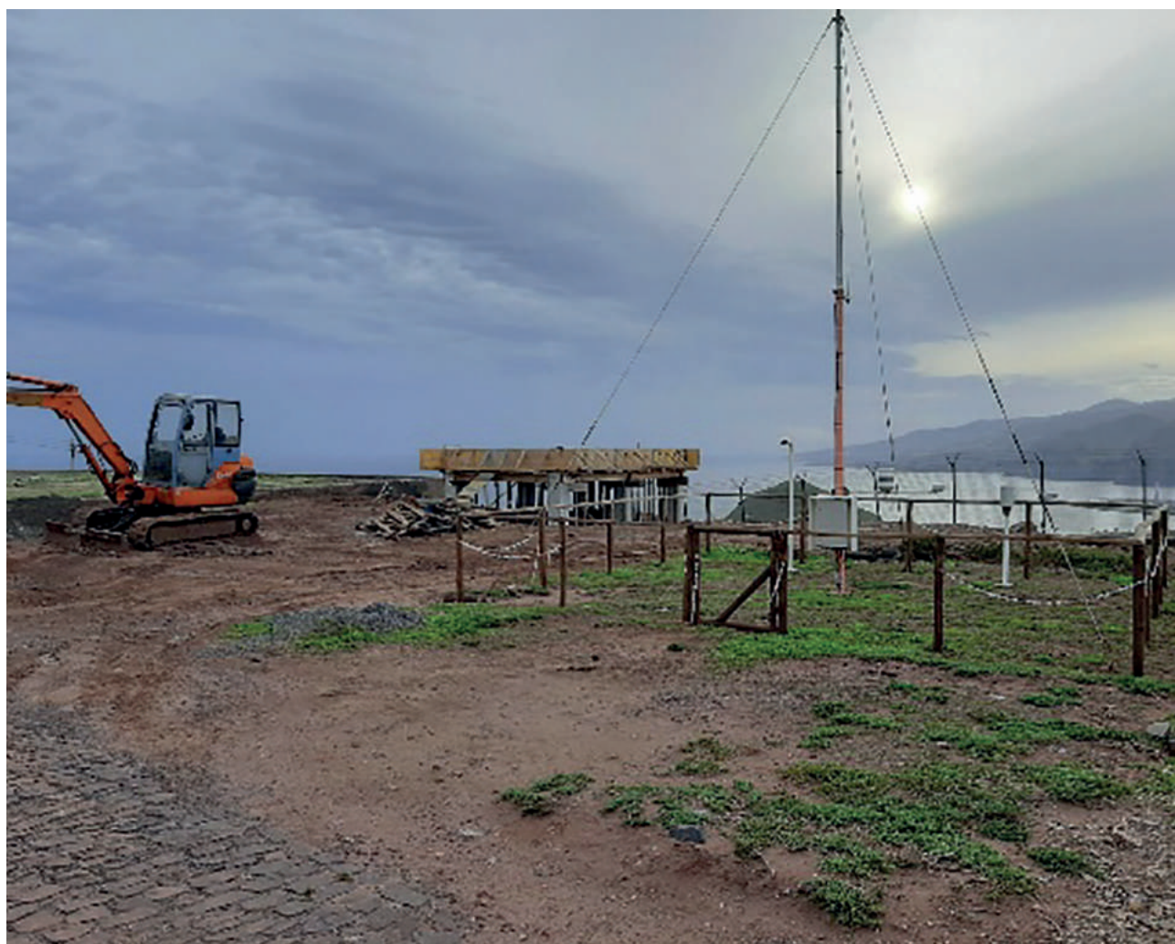
Figura 6 – Obras de preparação para Posto de Observação Fixo (SIVICC)
